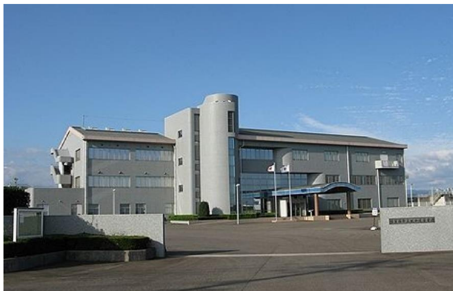
写真 5.1-1 佐賀西部広域水道企業団本庁舎
