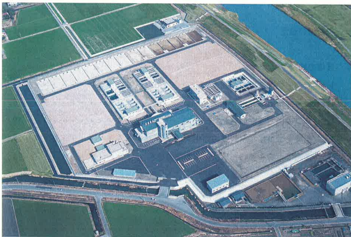
(嘉瀬川浄水場)
