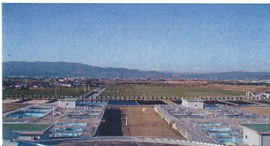
沈殿池・ろ過池
