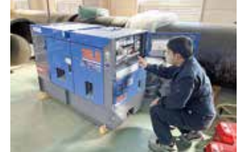
施設停電に備え、発電機準備
